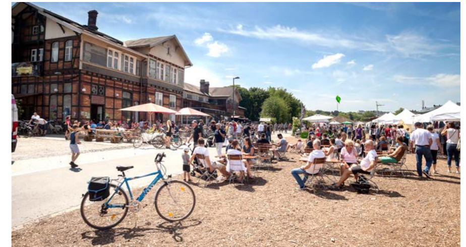
Einen „andauernden Gesellschaftskongress mit Ambitionen und Wirkung“ wird das Projekt Utopiastadt Wuppertal genannt. So wird beispielsweise der stillgelegte Mirker Bahnhof in Wuppertal von Bürgern und Bürgerinnen in Eigenregie umgebaut. In diesem Labor für kreative Stadtentwicklung entstehen ein Repaircafé, Treffpunkte, Co-Working Spaces und vieles mehr.
