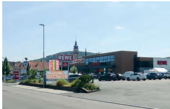
Supermarkt in Tauberbischofsheim (ca. 13.000 EW): Neubau im Anschluss an die Innenstadt und Teil des Zentralen Versorgungsbereichs. Wohnflächen mit fußläufigem Zugang durch die Schallschutzwand im direkten Umfeld.
