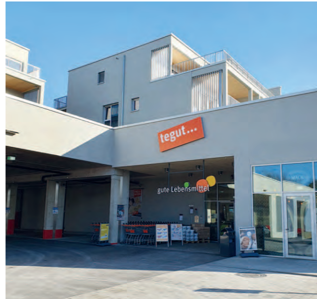
Supermarkt in Aalen (ca. 68.000 EW). Versorgung eines bisher unterversorgten und topografisch höher gelegenen Stadtteils. Umsetzung eines baulich integrierten Supermarkts mit einem auf Holzbau ausgerichteten architektonischen und ökologischen Konzept von merz objektbau in einem neuen Wohnquartier.
