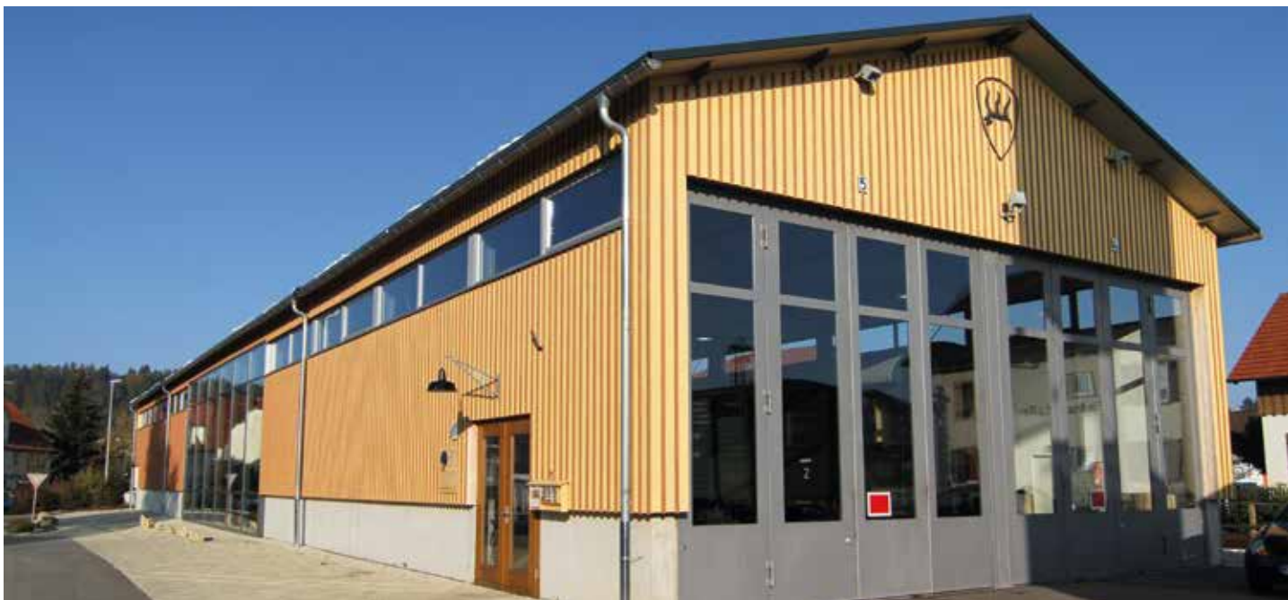
Münsinger Lokschuppen, moderne Ergänzung des historischen Ensembles Münsinger Bahnhof.
